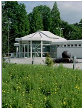
Haupteingang und Besucherservice des Forschungszentrums Geographische Lage: 50, 54', 23" (Nord); 6, 24', 14" (Ost)
